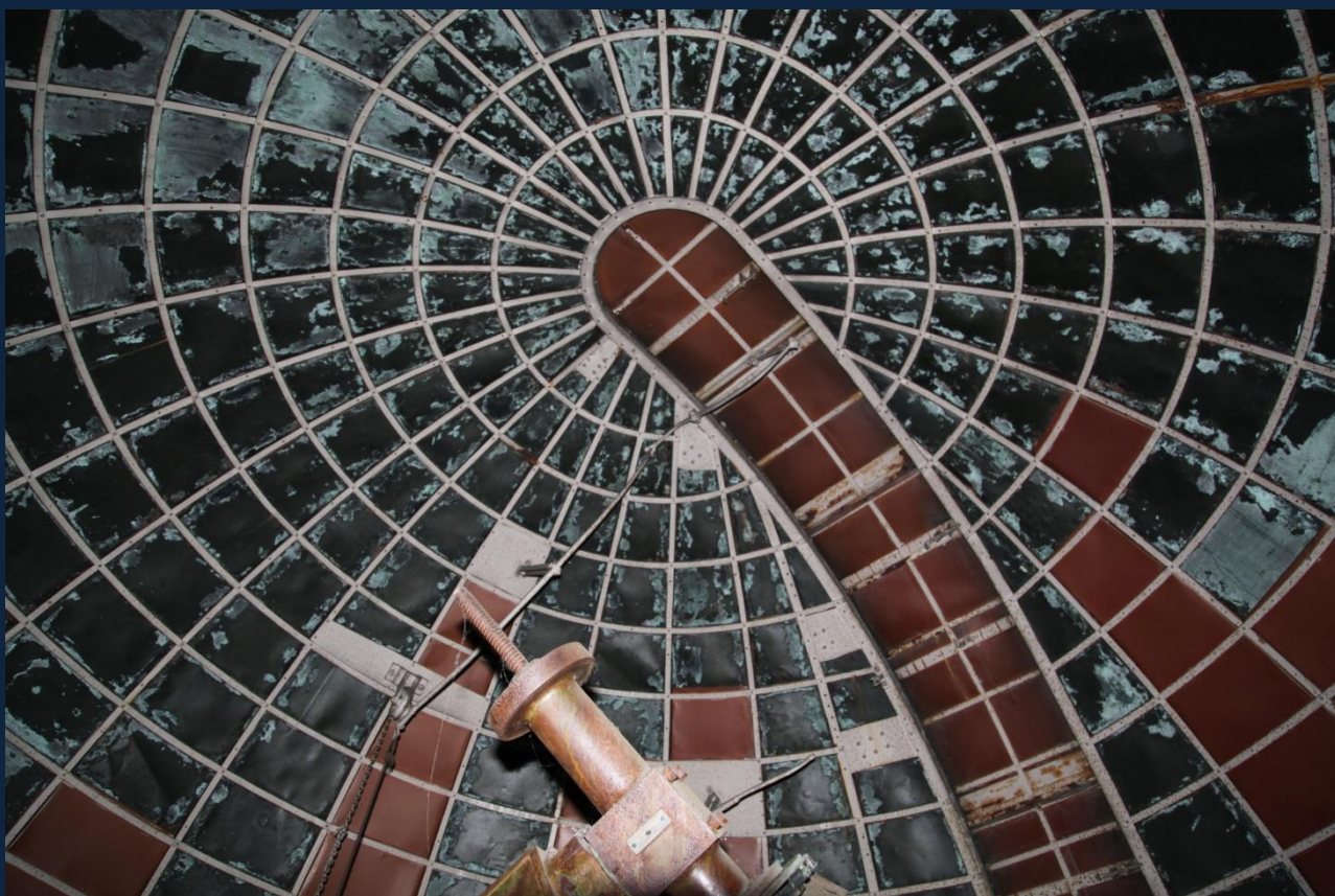
第一観測台内部
