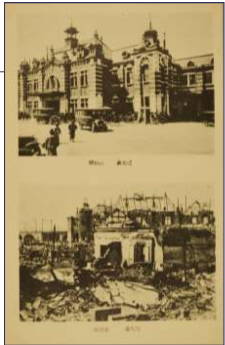
新橋駅 焼失前、焼失後
