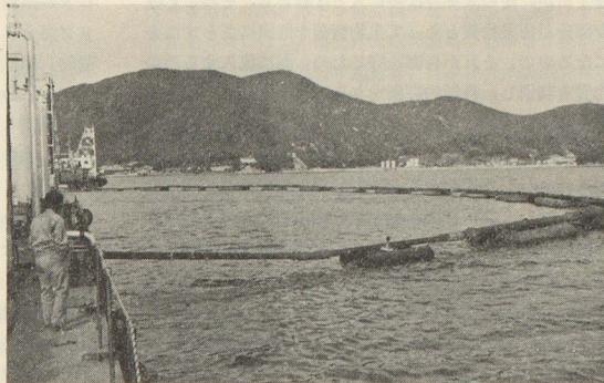
△カット 上方の浚渫船よりヘドロを処理船に移しているところ（坂越湾）
